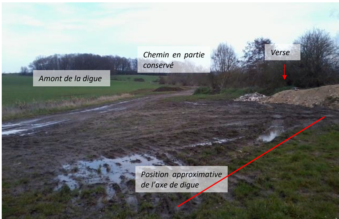
Photo 1 : Berlancourt – Vue du site depuis la bordure de la RD91
